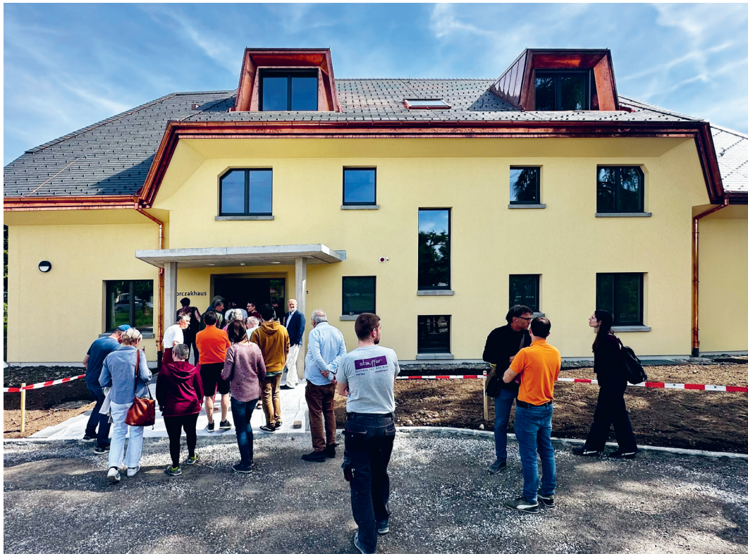
Besichtigung an der Abschlussfeier der Sanierungsarbeiten.
